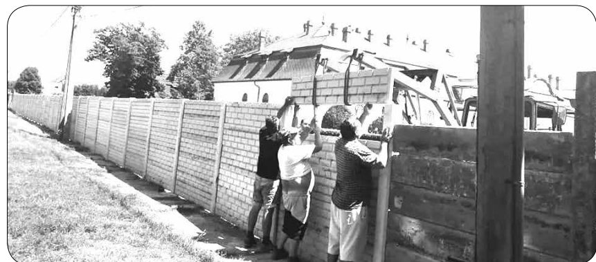
Szociális Otthon kerítés építés
